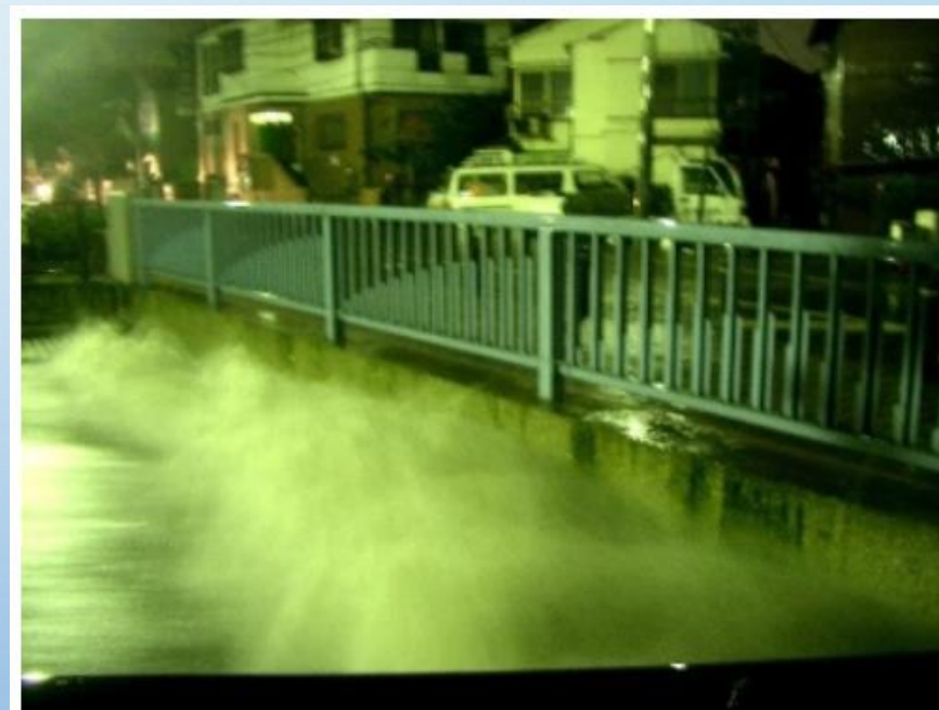
平成17年9月妙正寺川天神橋
